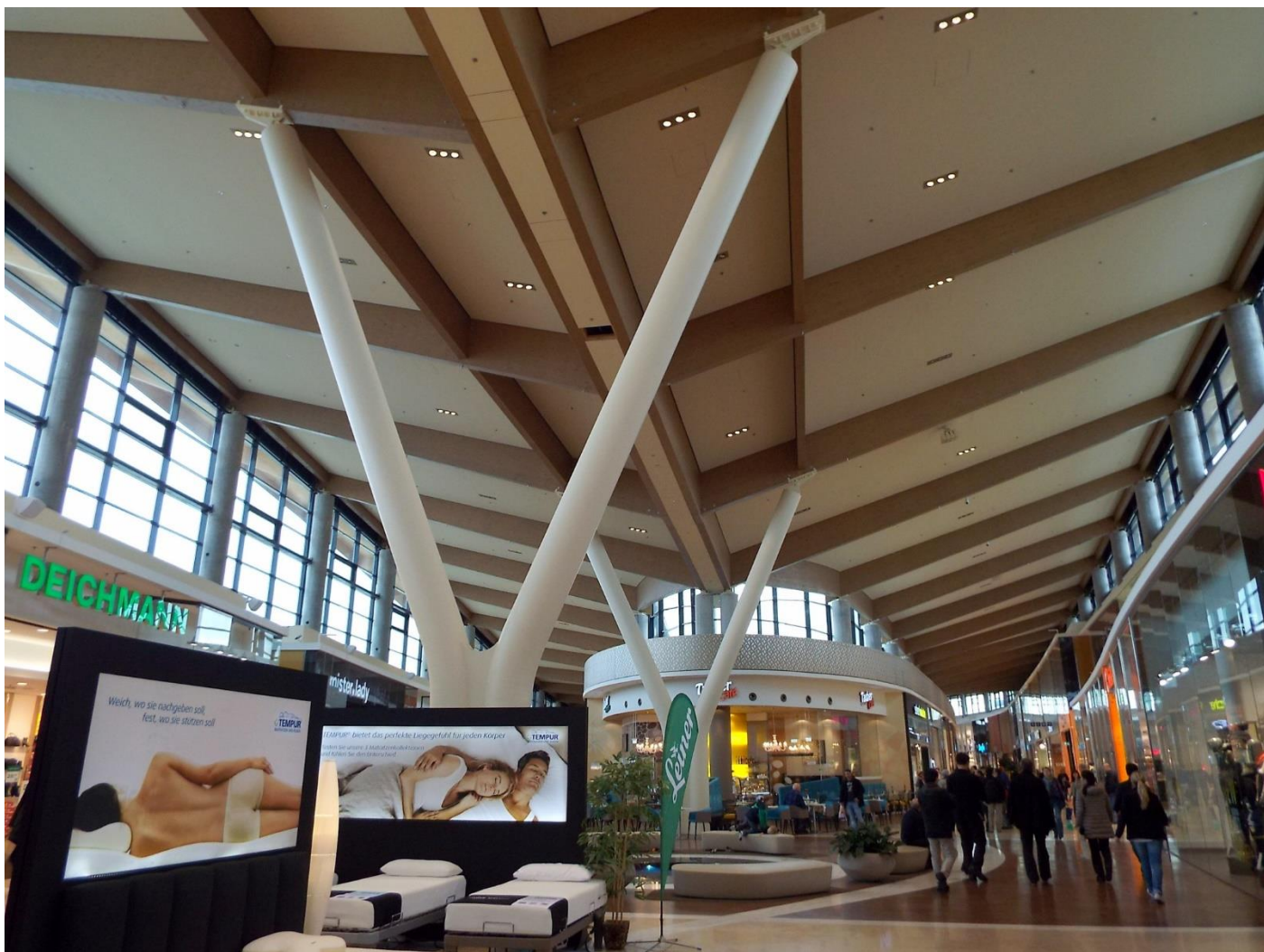
鉄骨やRCの柱に、集成材の現し梁、柱の長さを変えて曲面屋根を構成している。
